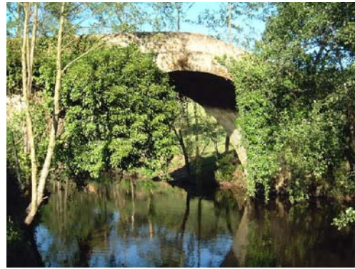
Ponte no fronteira co O Corgo sobor o río Tordea [Cat. nº 2.3-03]
